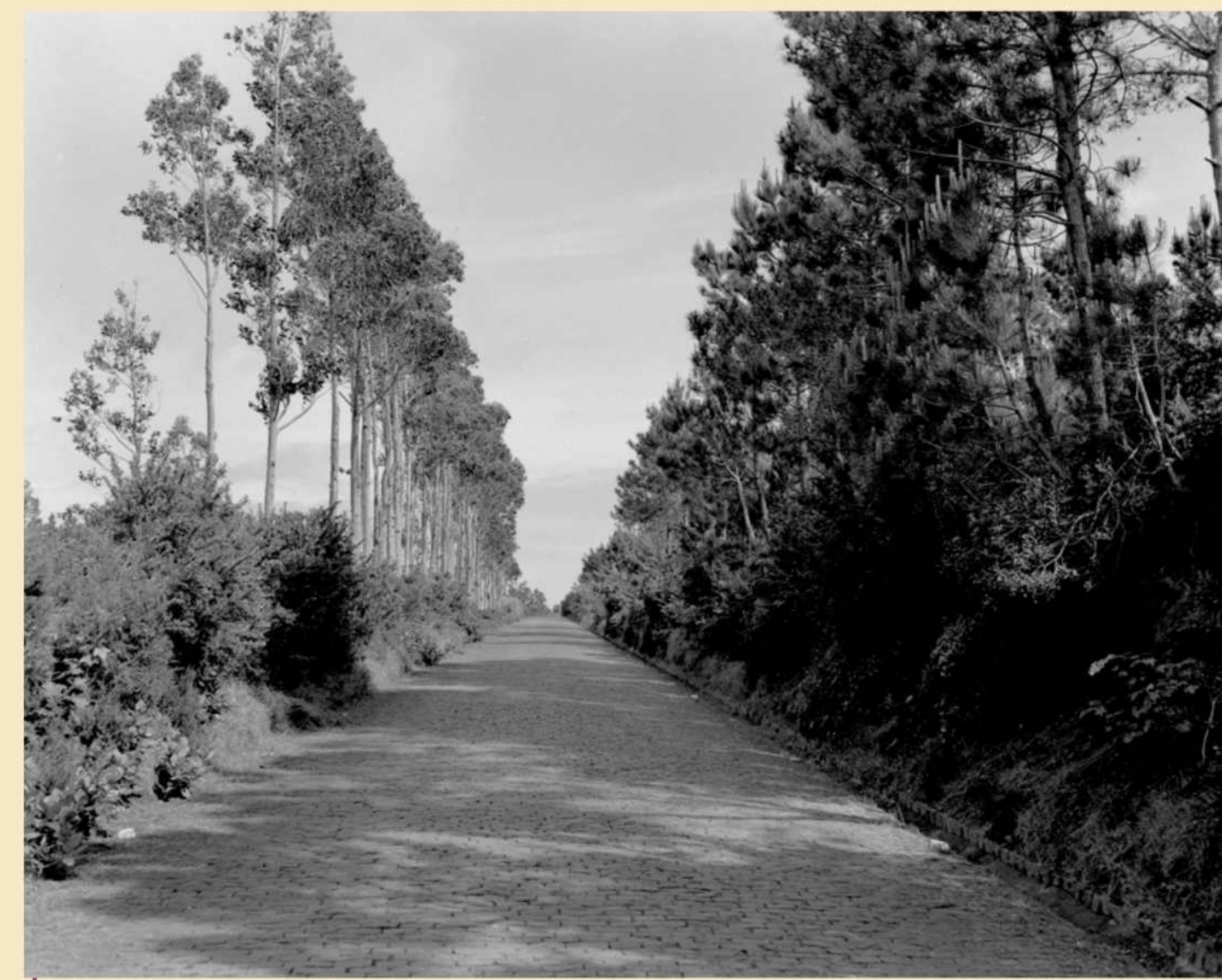
Estrada com pavimento em paralelepípedos de basalto; observam-se, a ladear a estrada, eucaliptos no lado esquerdo e pinheiros bravos no lado direito. Foto Perestrellos, post. 1930, negativo em película, MFM-AV, em depósito no ABM, PER/8076.
