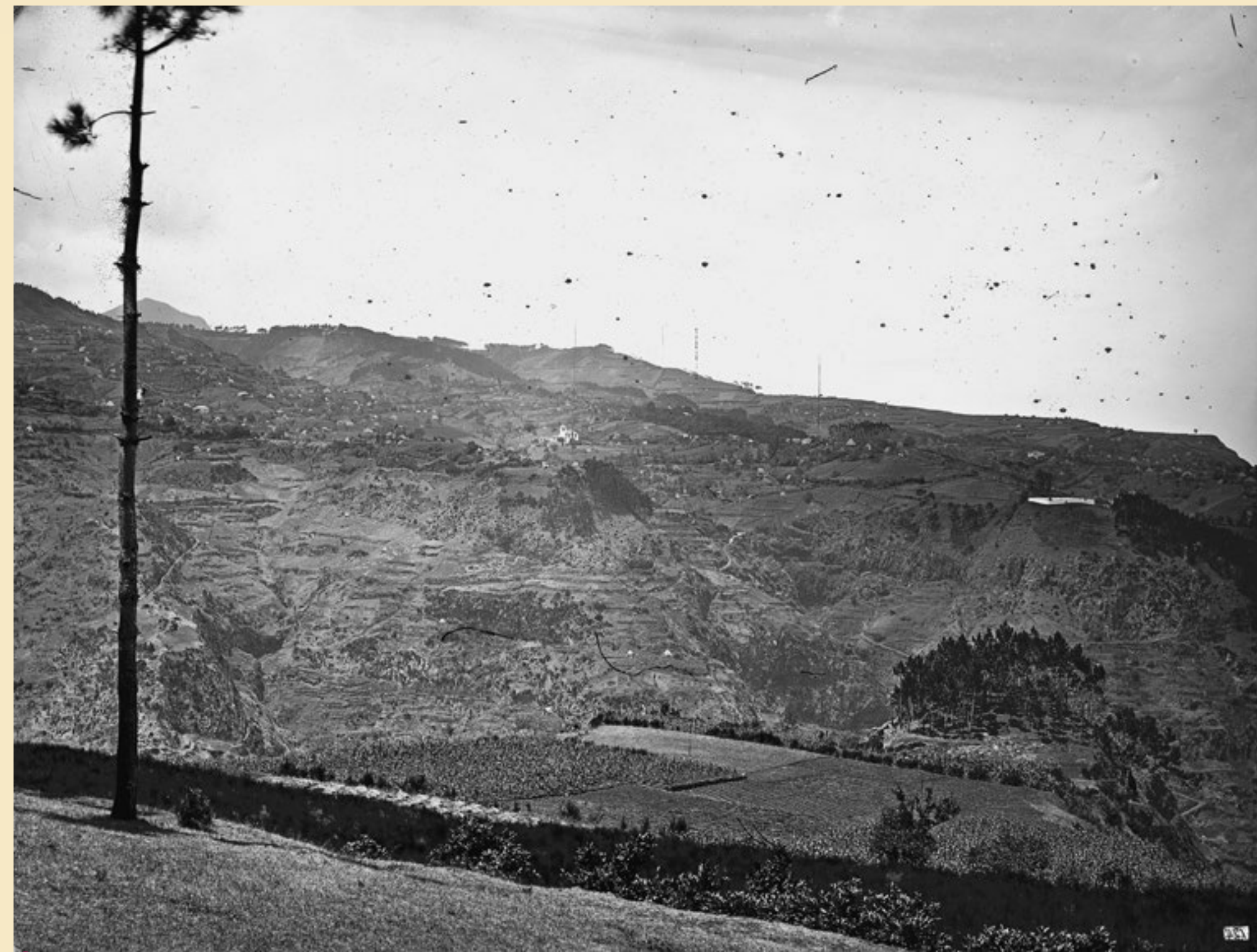
Panorâmica da freguesia de São Jorge, a partir do sítio da Achada do Gramacho; observam-se: ao centro, a igreja matriz de São Jorge; à direita, o muro caiado do cemitério, no sítio de São Pedro; na arriba, troços da Estrada Real 23. Foto Joaquim Augusto de Sousa, ant. 1905, negativo em vidro, MFM-AV, em depósito no ABM, JAS/145.
