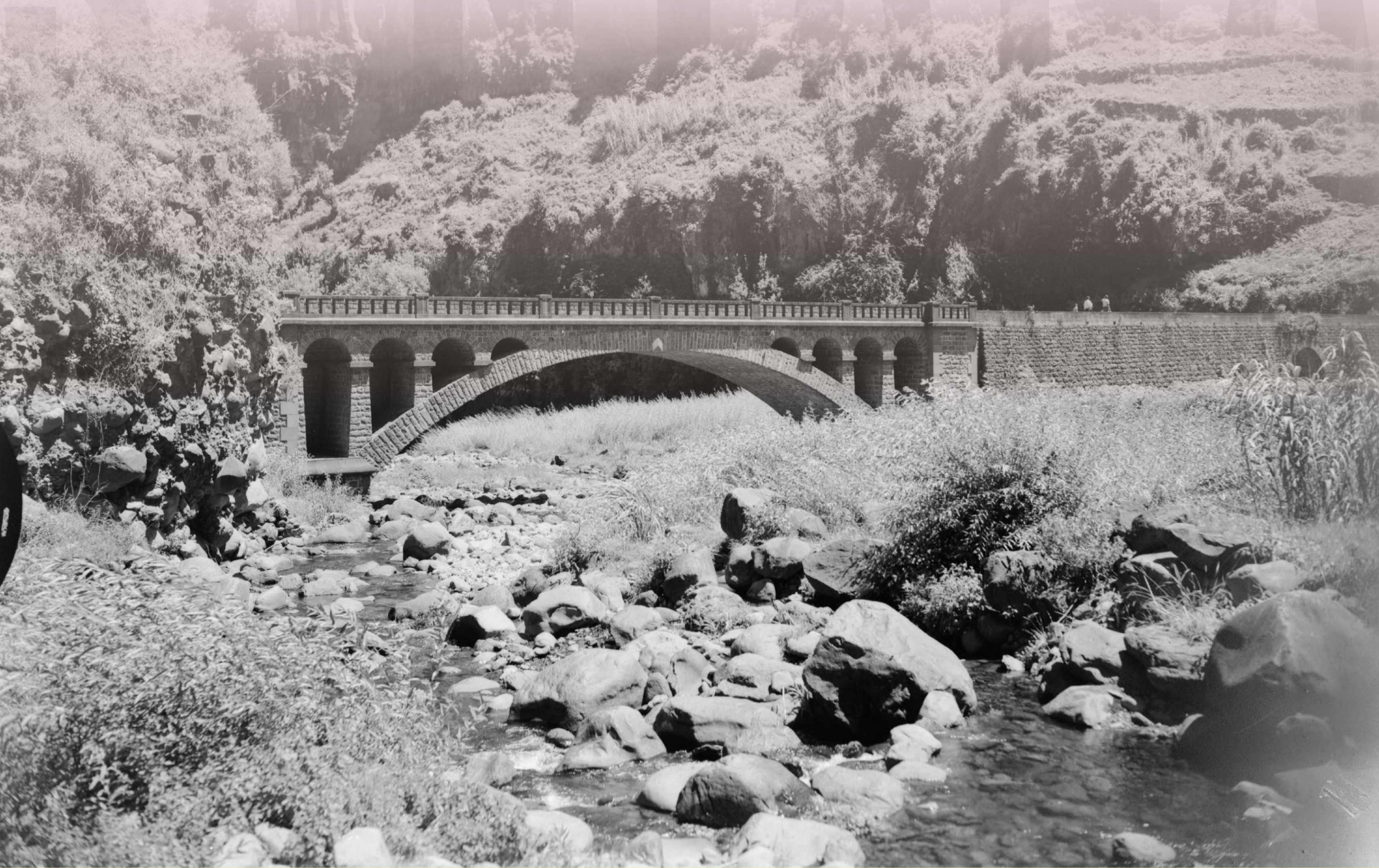
Ponte na ribeira de São Jorge; observam-se: os arcos do vão principal e as guardas de alvenaria no tabuleiro da ponte; à direita, dois homens e uma criança junto ao muro da ponte; e um arco secundário. Foto Perestrellos, post. 1949, negativo em película, MFM-AV, em depósito no ABM, PER/6817.
