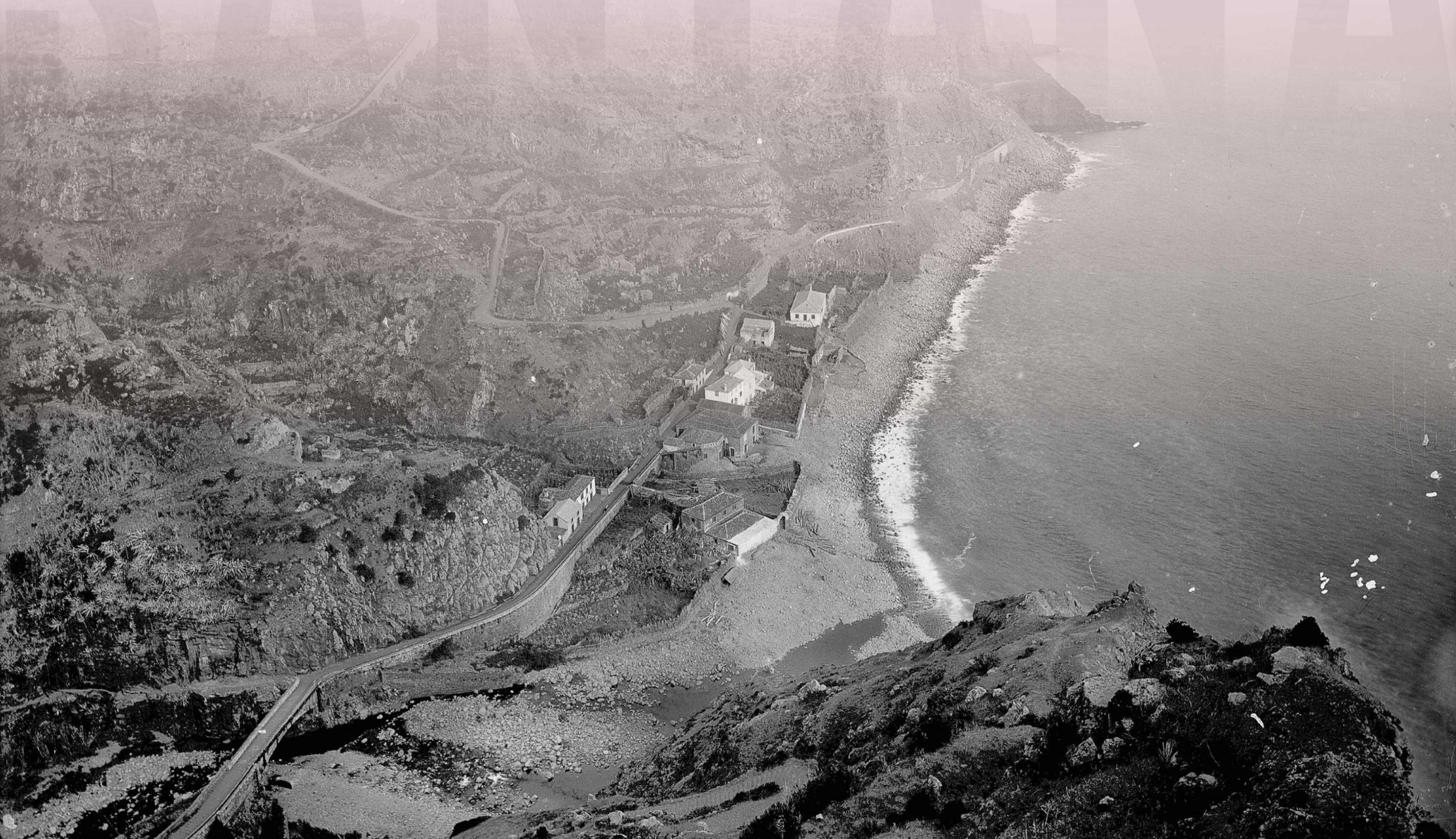
Vista do calhau de São Jorge, a partir do Cabeço da Vigia; observam-se: a ponte da Estrada Real 23 na foz da ribeira de São Jorge e a subida para o centro da freguesia; ao longo da costa, as ruínas do forte de São Jorge e da bateria de defesa da costa; um engenho de cana-de-açúcar de Manuel Romão da Cunha; casas com coberturas de telha; e o caminho para o calhau de São Jorge; no calhau, em frente da porta do forte, troncos de madeira e uma embarcação. Foto Perestrellos, entre 1875 e 1899, negativo em vidro, MFM-AV, em depósito no ABM, PER/10.
