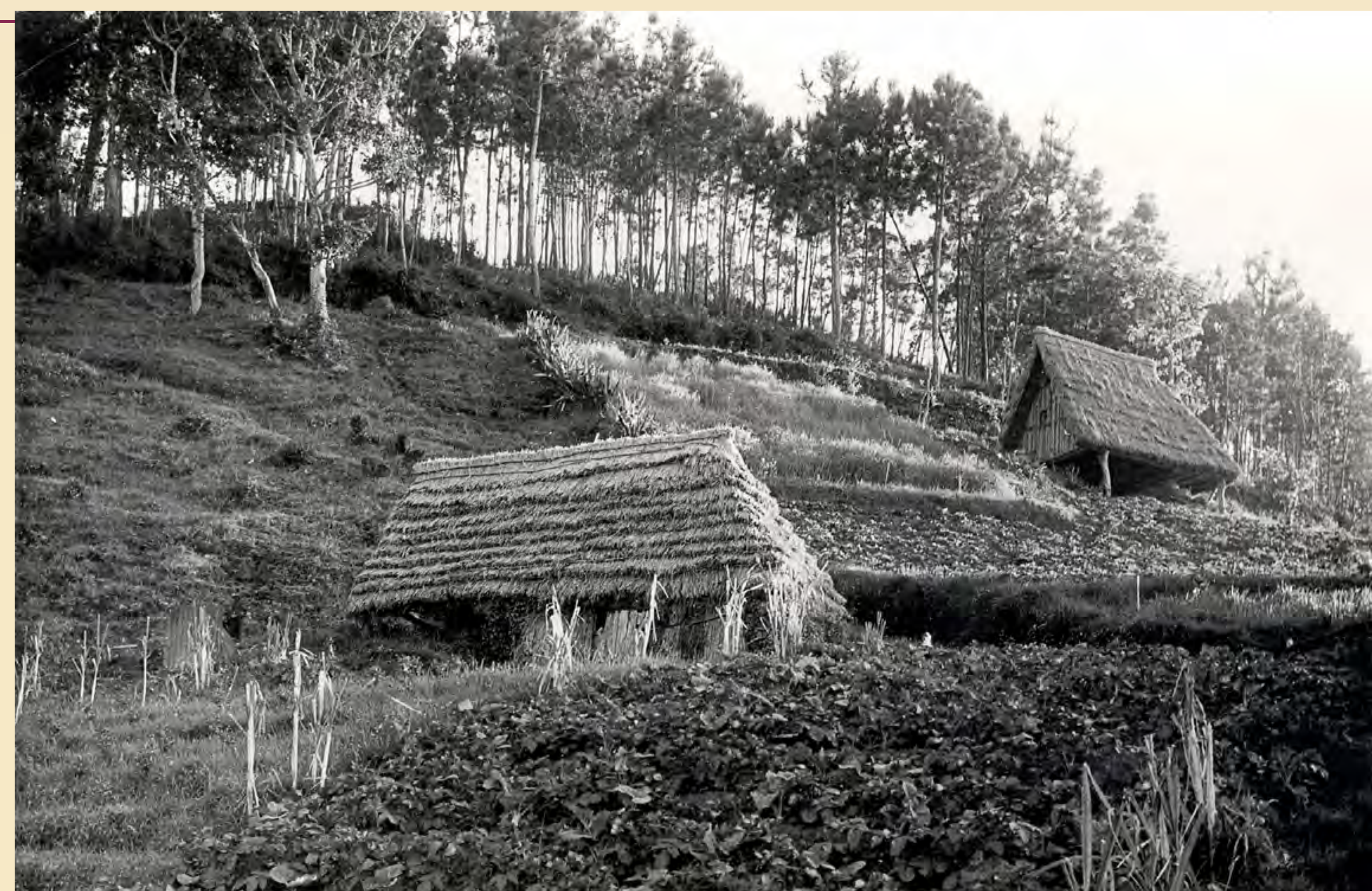
Casa de madeira com cobertura de colmo, no Lombo do Curral; observam-se: em primeiro plano, o jardim e uma cerca em canaveira; à esquerda um poio com couves; o terreno calcetado; na empena, a porta de acesso e pinhas de maçoarocas em sequeiro; e um arame e molas de madeira do estendal. Foto Rosado, 1970, prova fotográfica, COLFOT, m1012.
