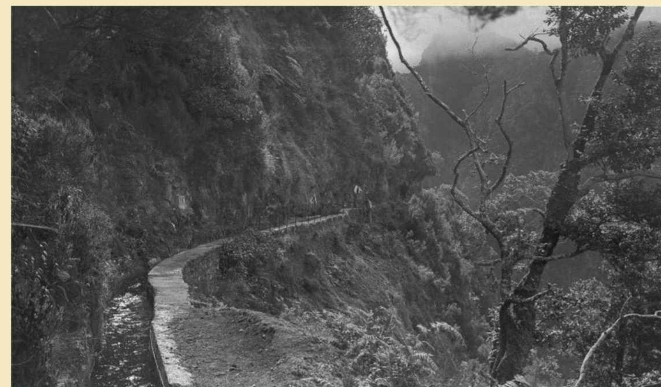
Levada do Caldeirão Verde, no sítio das Queimadas; observam-se: a vereda ao lado da levada, em parte protegida por um varandim metálico; ao fundo, ferramentas e dois homens a prolongarem o varandim; e um homem a percorrer a levada. Foto Figueiras, post. 1930, negativo em vidro, MFM-AV, em depósito no ABM, PHF/154.
