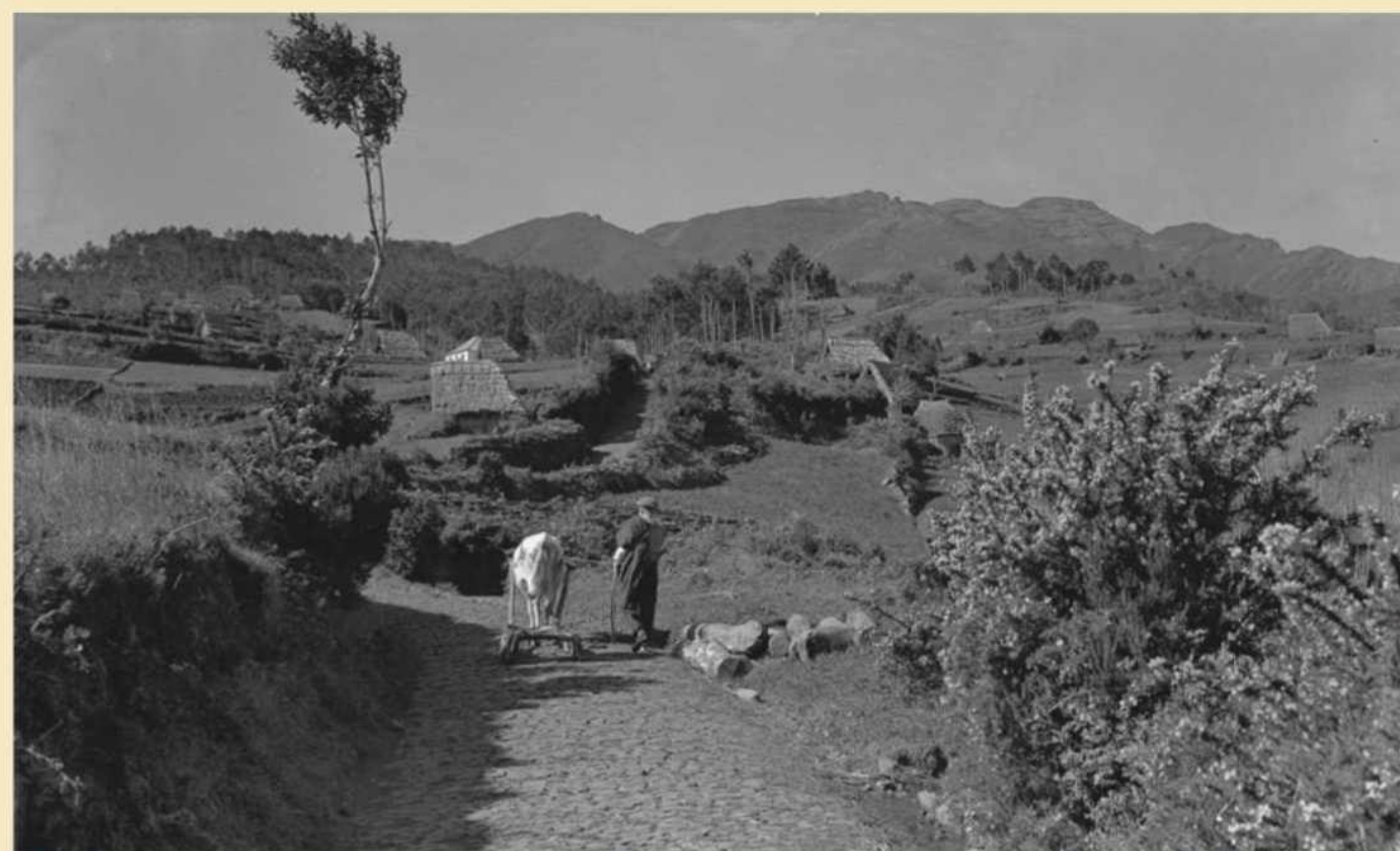
Vista da freguesia de Santana, a partir do sítio do Atalho; observam-se: um homem a conduzir um boi com canga atrelada a uma corsa e troncos de madeira na orla do caminho; diversas casas com coberturas de colmo e uma casa com cobertura em telha; ao fundo, o sítio da Achada do Teixeira e o Pico Ruivo. Foto Figueiras, post. 1930, negativo em vidro, MFM-AV, em depósito no ABM, PHF/127.
