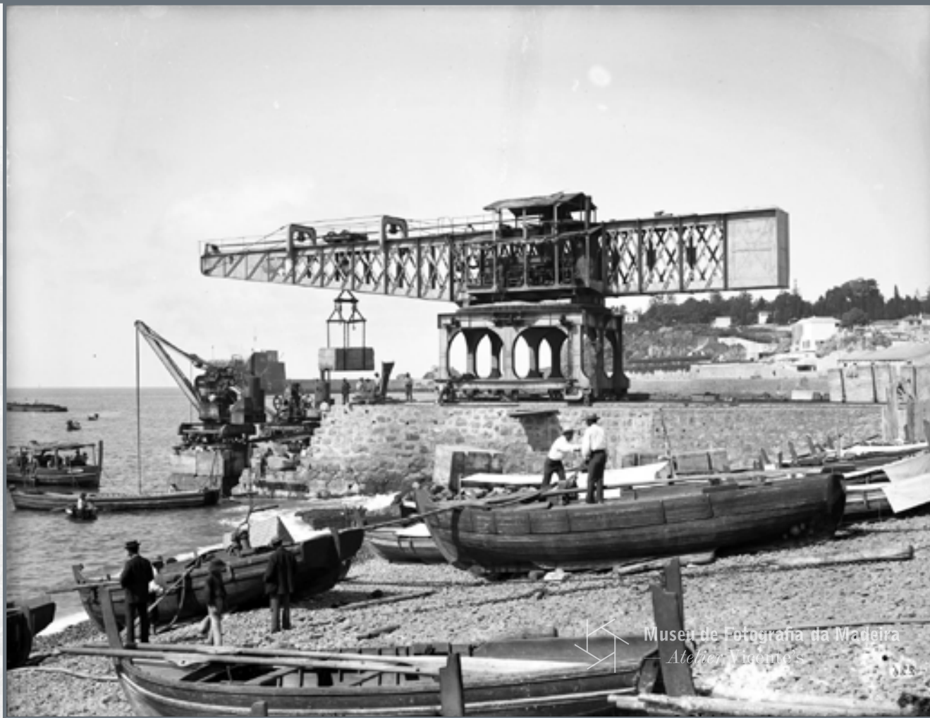
Cais da cidade do Funchal em fase de construção, Freguesia da Sé, Concelho do Funchal, c. 1890, MFM-AV, em depósito no ABM, JAS/587
