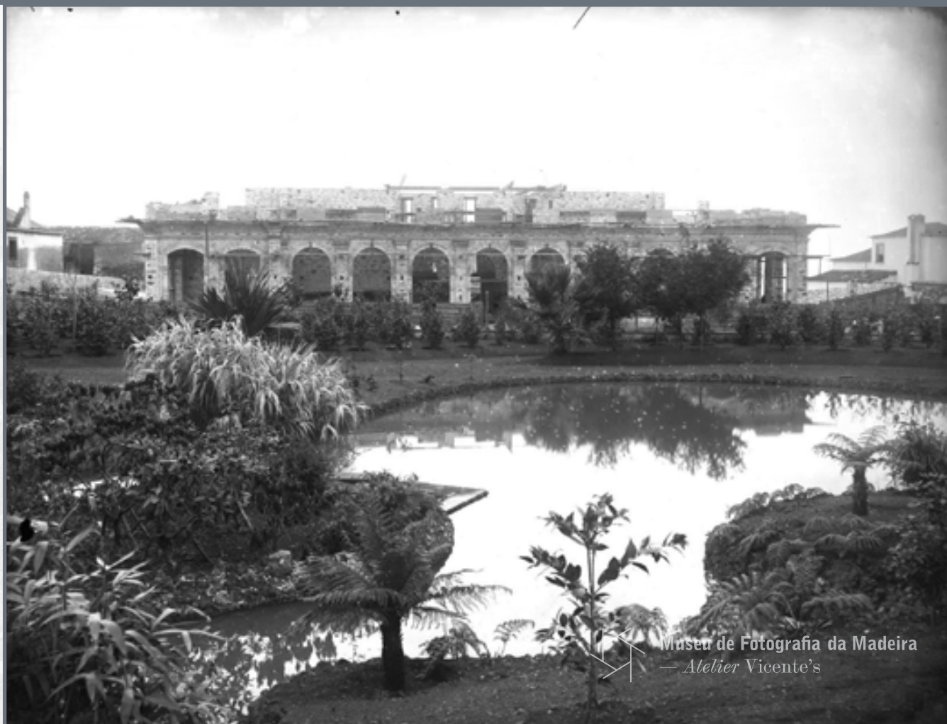
Teatro D. Maria Pia (atual Teatro municipal Baltazar Dias) em fase de construção e lagoa do Jardim Municipal, Freguesia da Sé, Concelho do Funchal, Entre 1883 e 1887, MFM-AV, em depósito no ABM, JAS/558
